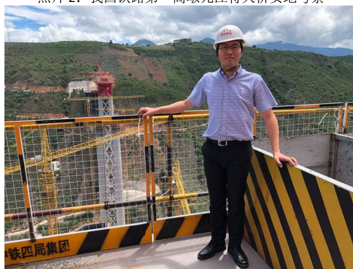
照片 2：我国铁路第一高墩元江特大桥实地考察
